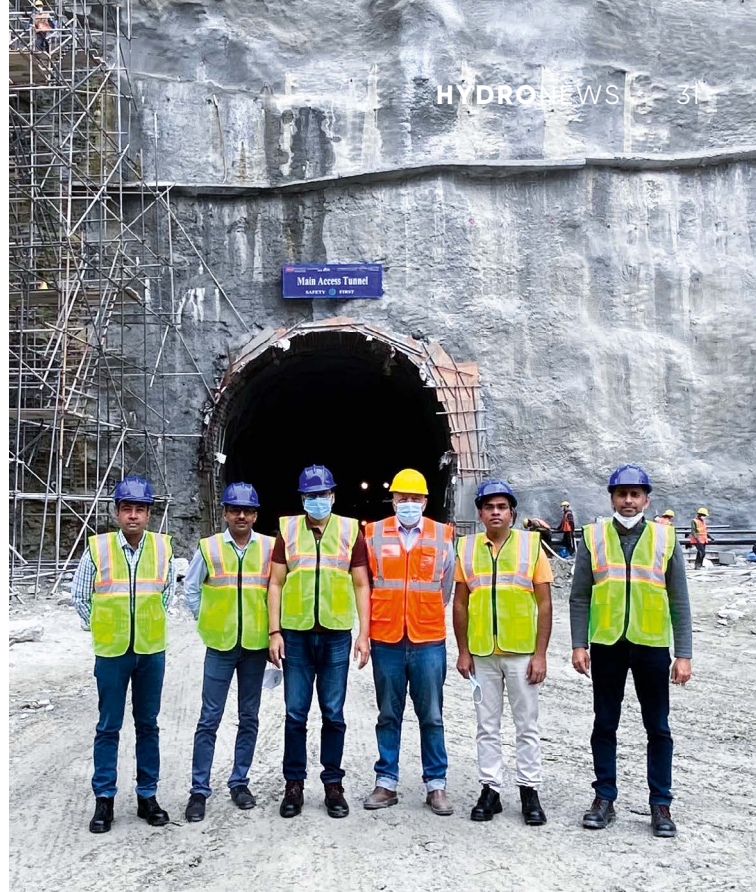
目前,该项目工程正在有条不紊地推进中。 该项目的建设周期为五年,计划于2026年12月完工。
