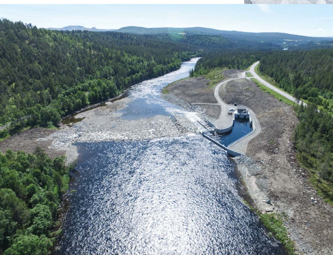
鱼类友好型水电站解决方案。 这种进水口拦污栅可让鱼类安全地经过进水口到达旁路通道。
