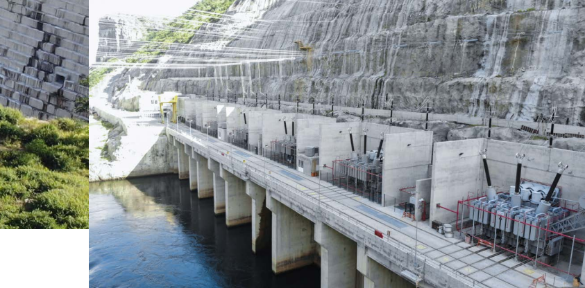
新建的LAÚCA水电站不仅提高了该国的总体发电量,而且还成为安哥拉现代电网调节的主力。
