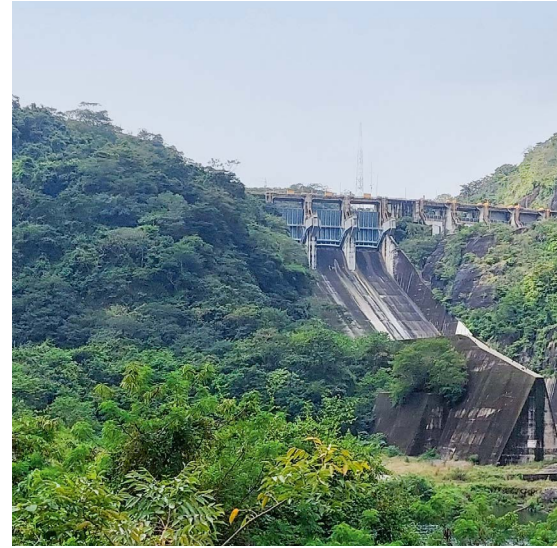
马尔帕索水电站的大坝和溢洪道
