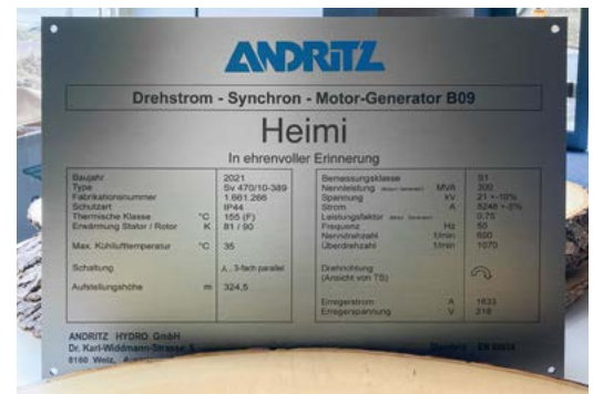
Placa de identificación de la unidad B09
