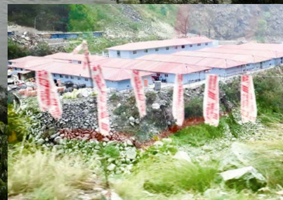
Campamento de obras en el río Upper Trishuli.
