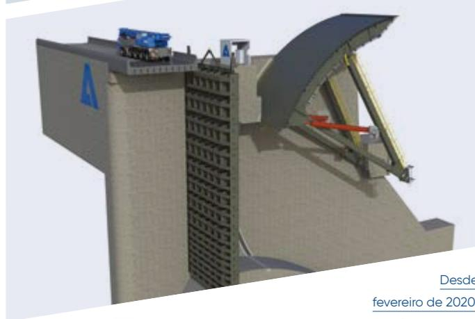
comportas de saída de fundo com capota para fluxo ecológico, tampões para todas as comportas, máquina de limpeza de resíduos e as tubulações de pressão para as unidades geradoras.
