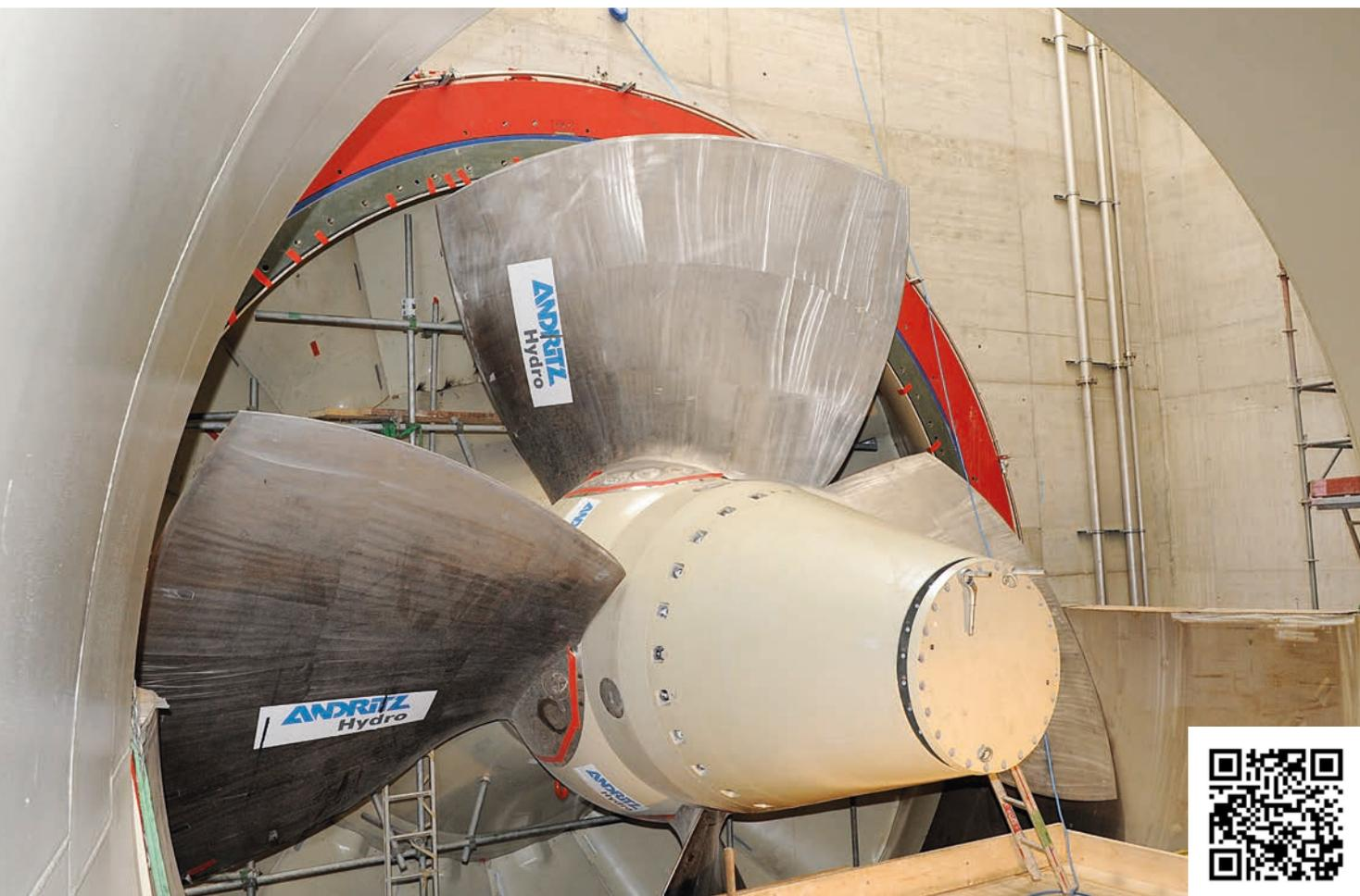
Installation d'une turbine Bulbe dans la centrale hydroélectrique d'Iffezheim en Allemagne
