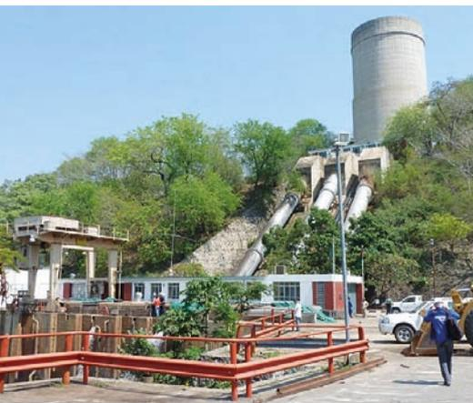
Le consortium dirigé par ANDRITZ HYDRO fournira la modernisation des prises d'eau et des aspirateurs, les conduites forcées, l'installation des roues de la turbine et des composants fixes de la turbine, les nouveaux alternateurs complets, les systèmes auxiliaires mécaniques et électriques ainsi qu'un nouveau poste haute tension et un système SCADA.
