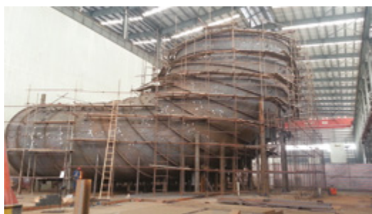
Installation du tube d'aspirateur
