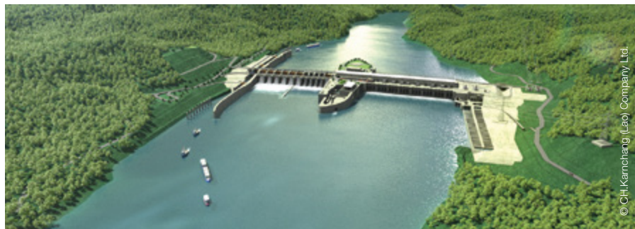
L'écluse, le déversoir, le bloc intermédiaire, la centrale et l'échelle à poissons
