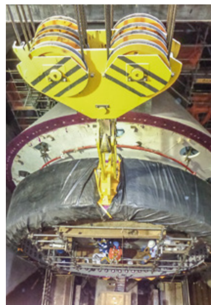
Installation de l'alternateur Bulbe
